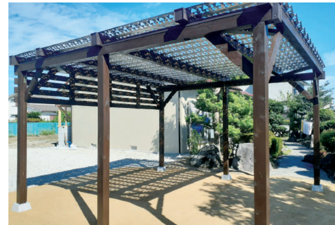
北千里駅前 休憩所 兵庫県 個人宅
