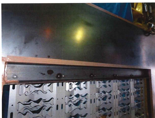
写真5 フラクタルの固定状況（屋内側）
