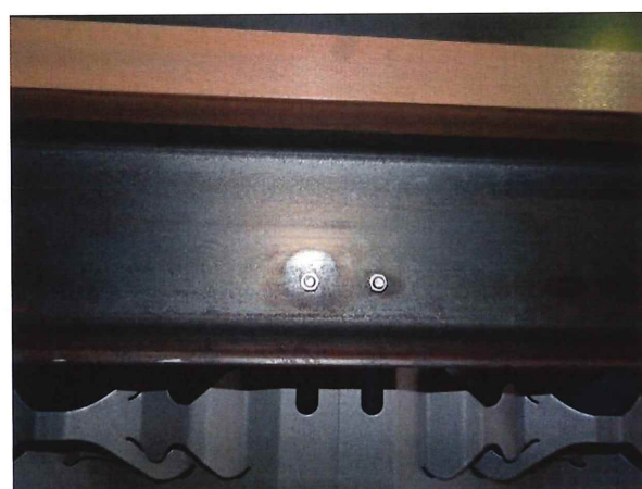
写真6 フラクタルの固定状況（屋内側）
