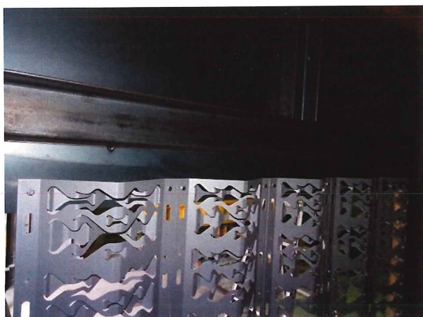
写真3 フラクタルの固定状況（屋外側）
