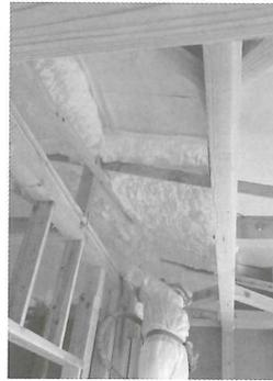
母屋間に現場発泡断熱材を吹き付け施工する際に用いるもの。一般的な透湿・防水シートを屋根用下地通気部材として用いると、発泡断熱材の膨張により通気層を塞いでしまいう懸念があるが、ABSSエアネットでは、遮熱性を持たせた透湿・防水シート「ABSS」と、特殊樹脂ネットを貼り合わせることで、発泡断熱材のシートへの密着性、シート自体の強度を高めた。これにより発泡断熱材の膨張により通気層を塞ぐ懸念を解消。確実に通気層を確保できるようにした。
